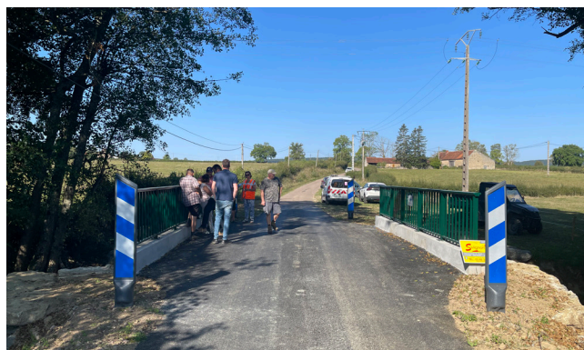
Les travaux du pont de l'Écheriolle ont été réalisés en juillet.
